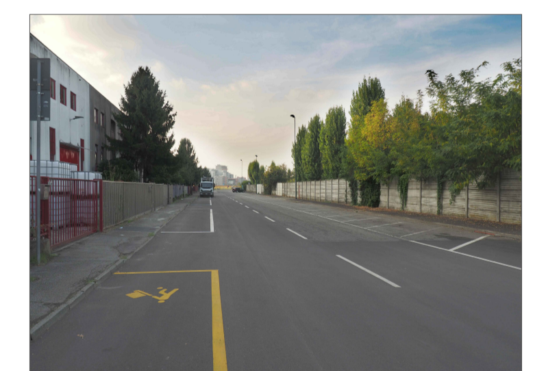
La recinzione cieca in CLS su via Daniele Manin
