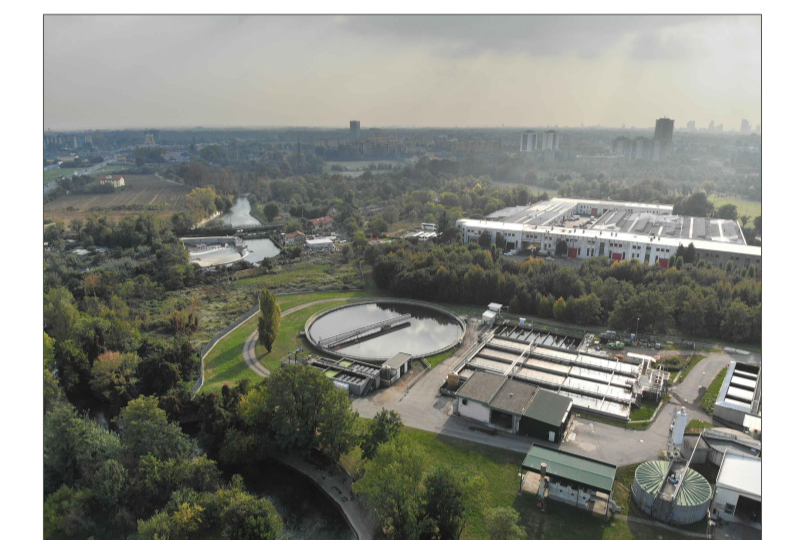
La fascia boscata CAP di via Daniele Manin verso il Lambro a Sud
