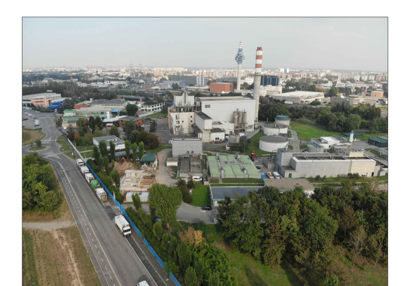
La eterogeneità dei volumi edili e degli impianti, camion in attesa lungo via Manin
